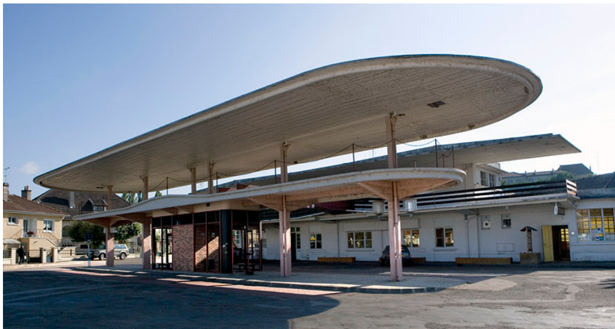
Station bus avec auvents.
