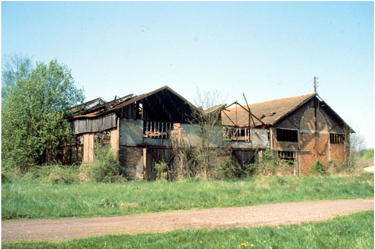
Forge Neuve. Atelier de construction : façade antérieure.
