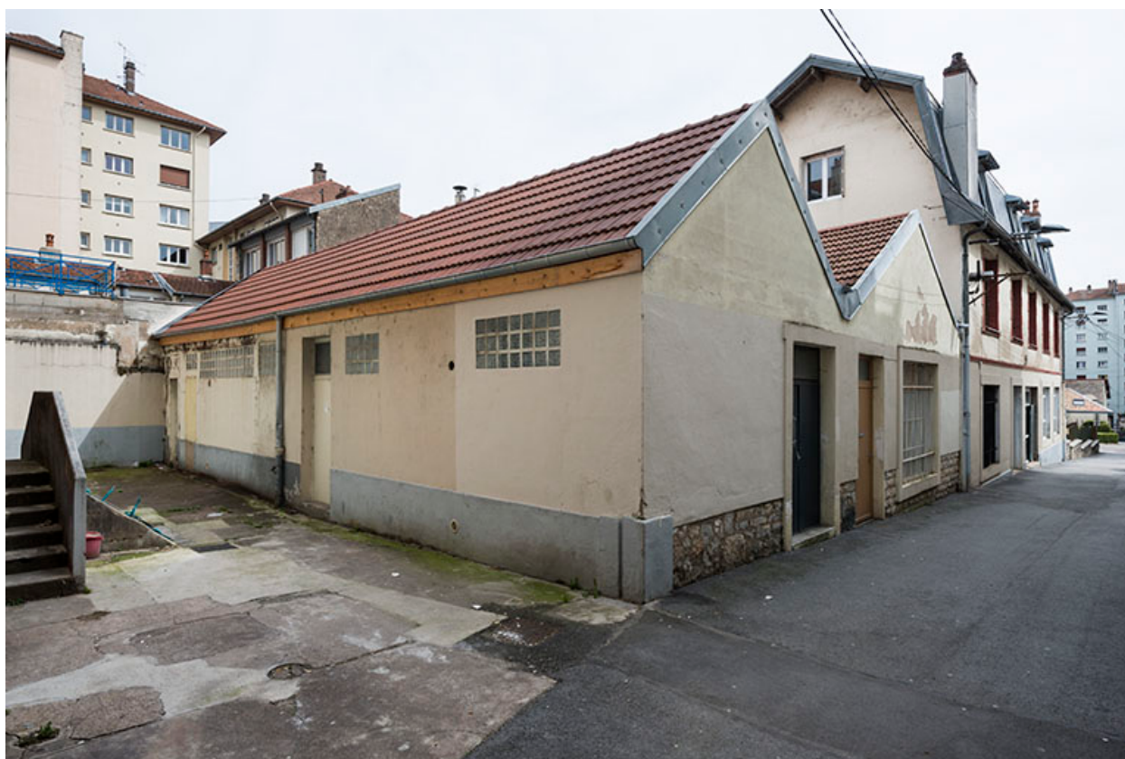
Vue depuis le nord de l'impasse Rambaud.
