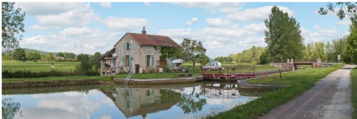
Vue d'ensemble du site d'écluse.
