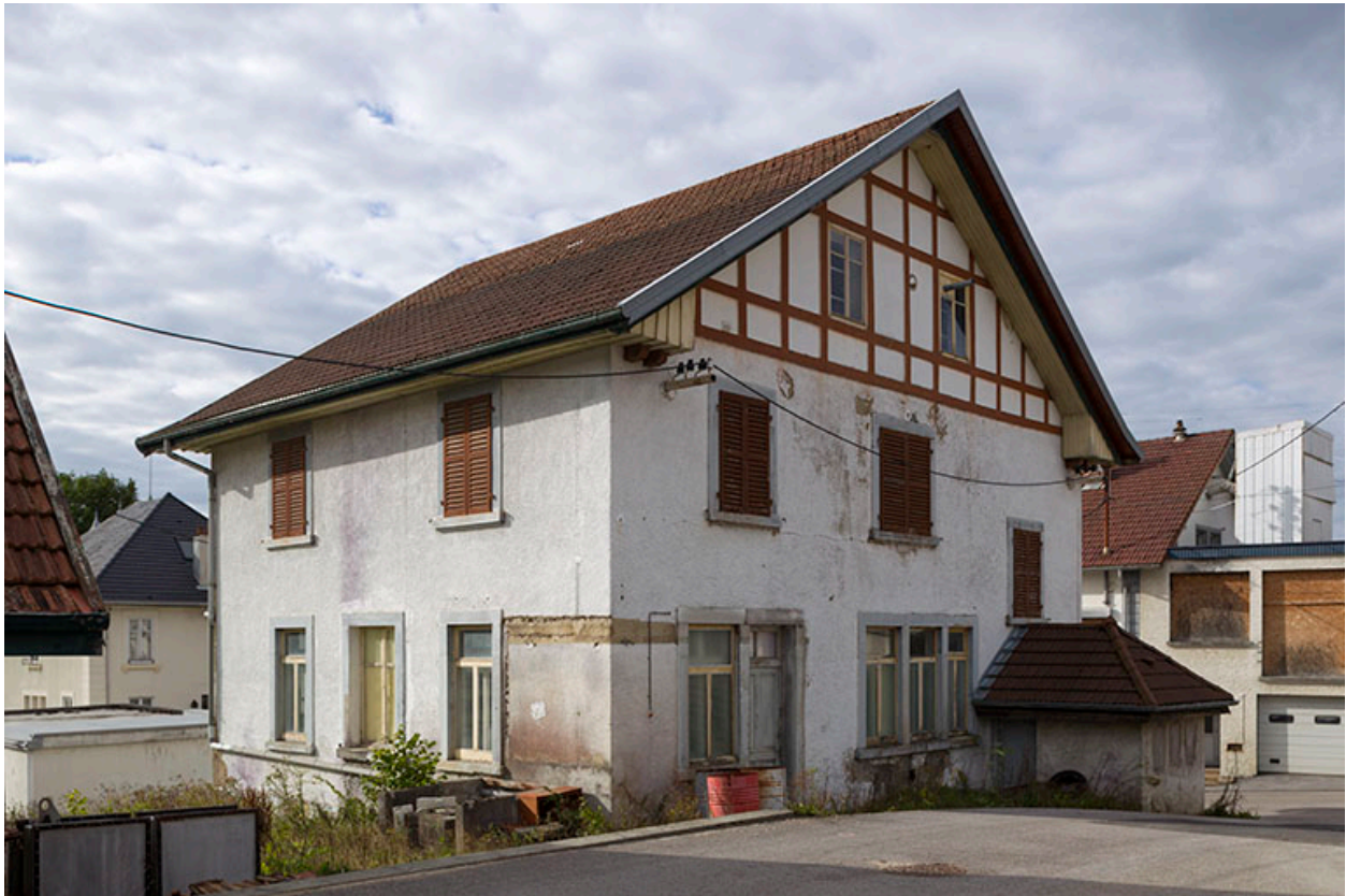
Deuxième bâtiment, au 4 rue Victor Hugo : façades postérieure et latérale droite.
