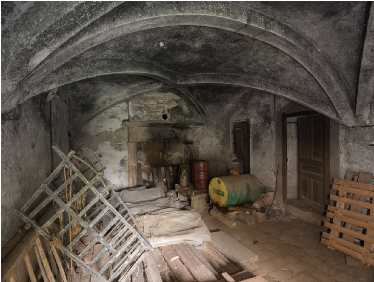
Pièce principale voûtée (ancienne cuisine ?) du rez-de-chaussée de la tour
