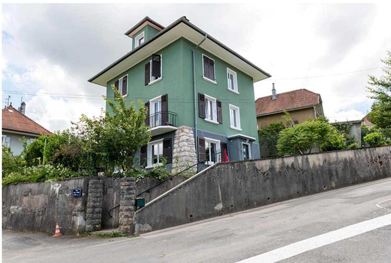
Façades antérieure et latérale droite.
