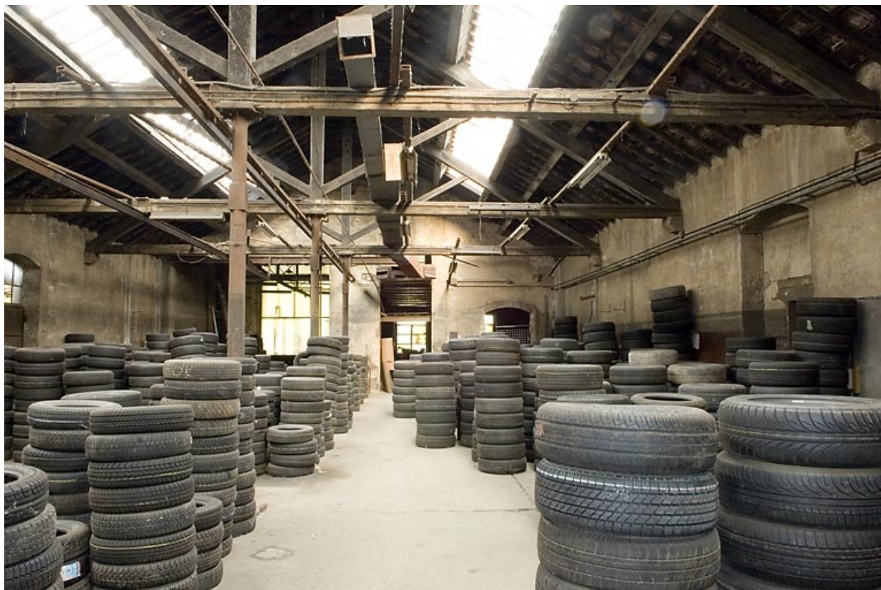
Charpente et couverture de l'atelier de fabrication.
