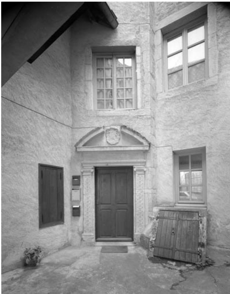
Détail : porte d'entrée de l'escalier en vis.
