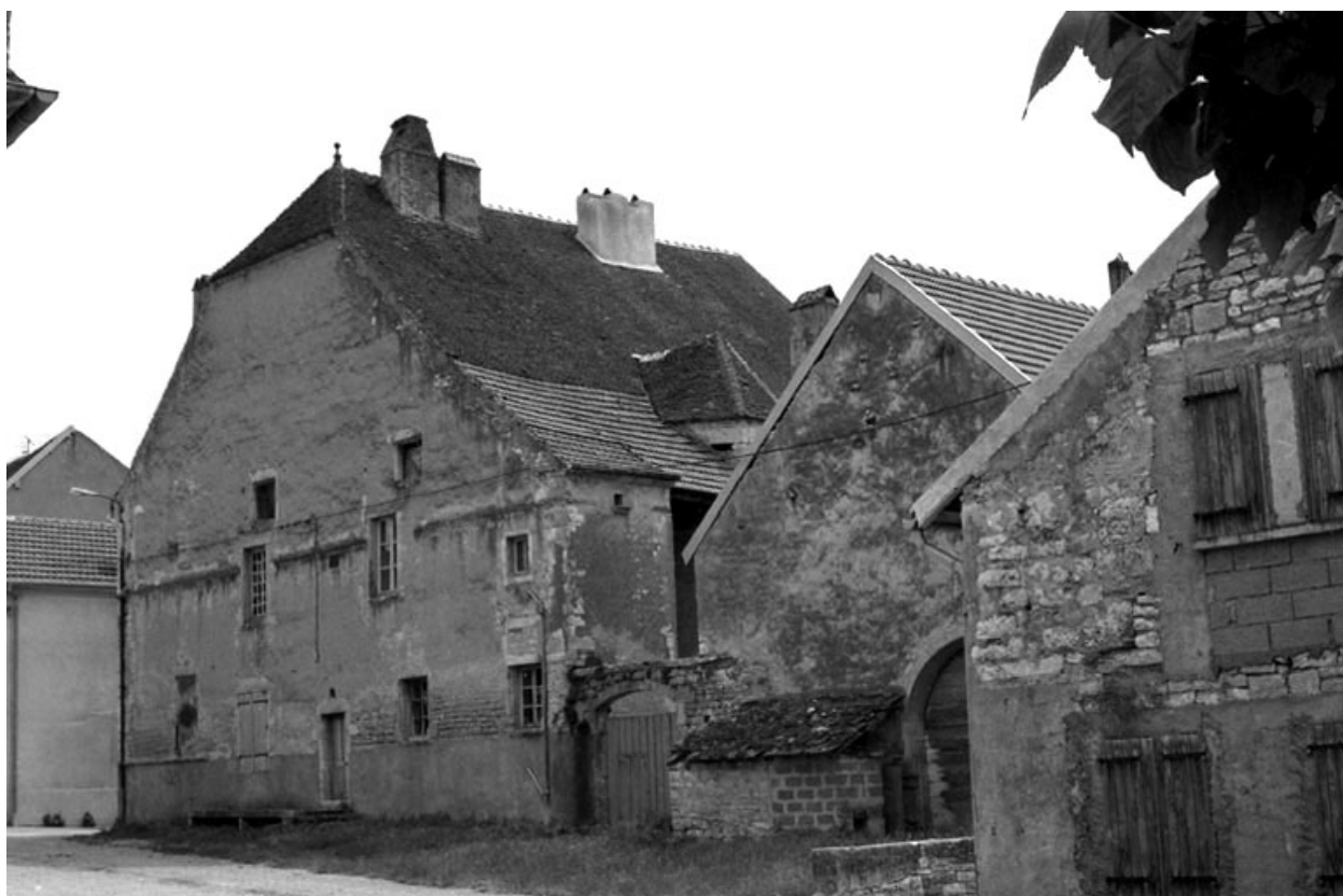
Façade latérale droite.
