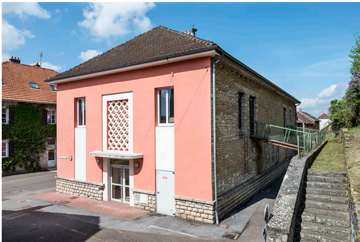
Le mur pignon sud.
