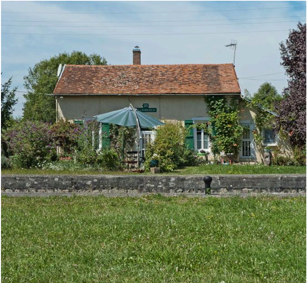
Vue de face de la maison éclusière.
