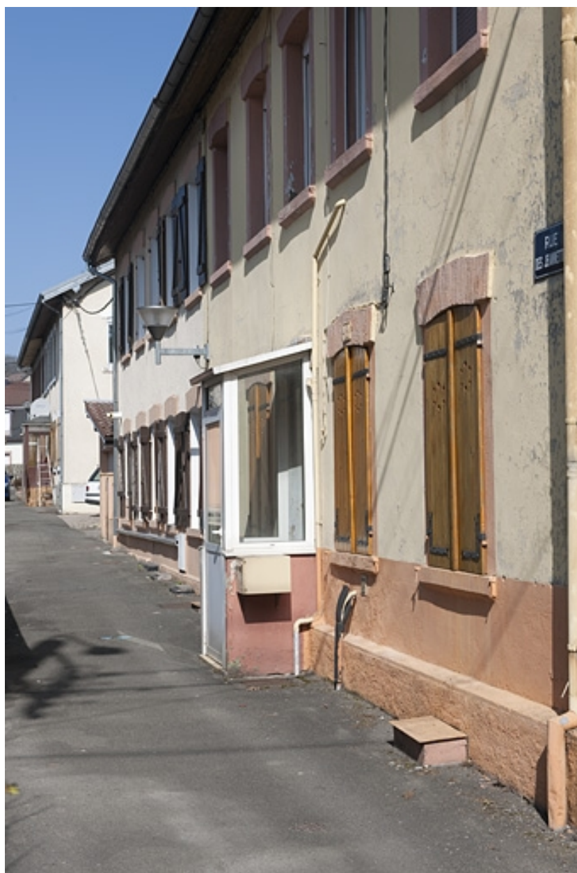
Détail d'une façade d'une habitations à 8 logements.
