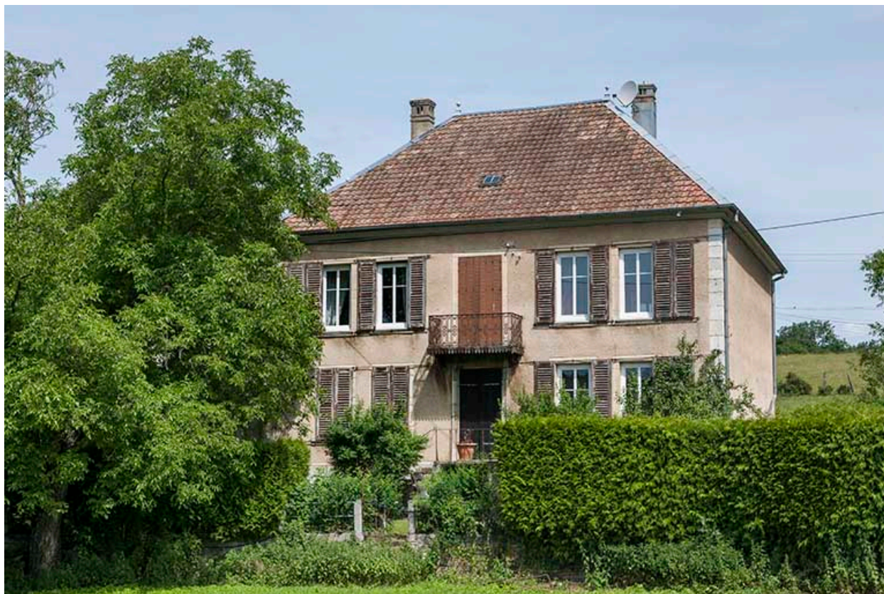
Façade sud du logement.
