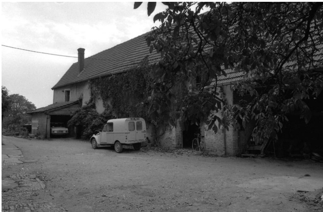
Bâtiment de droite : façade sur cour.
