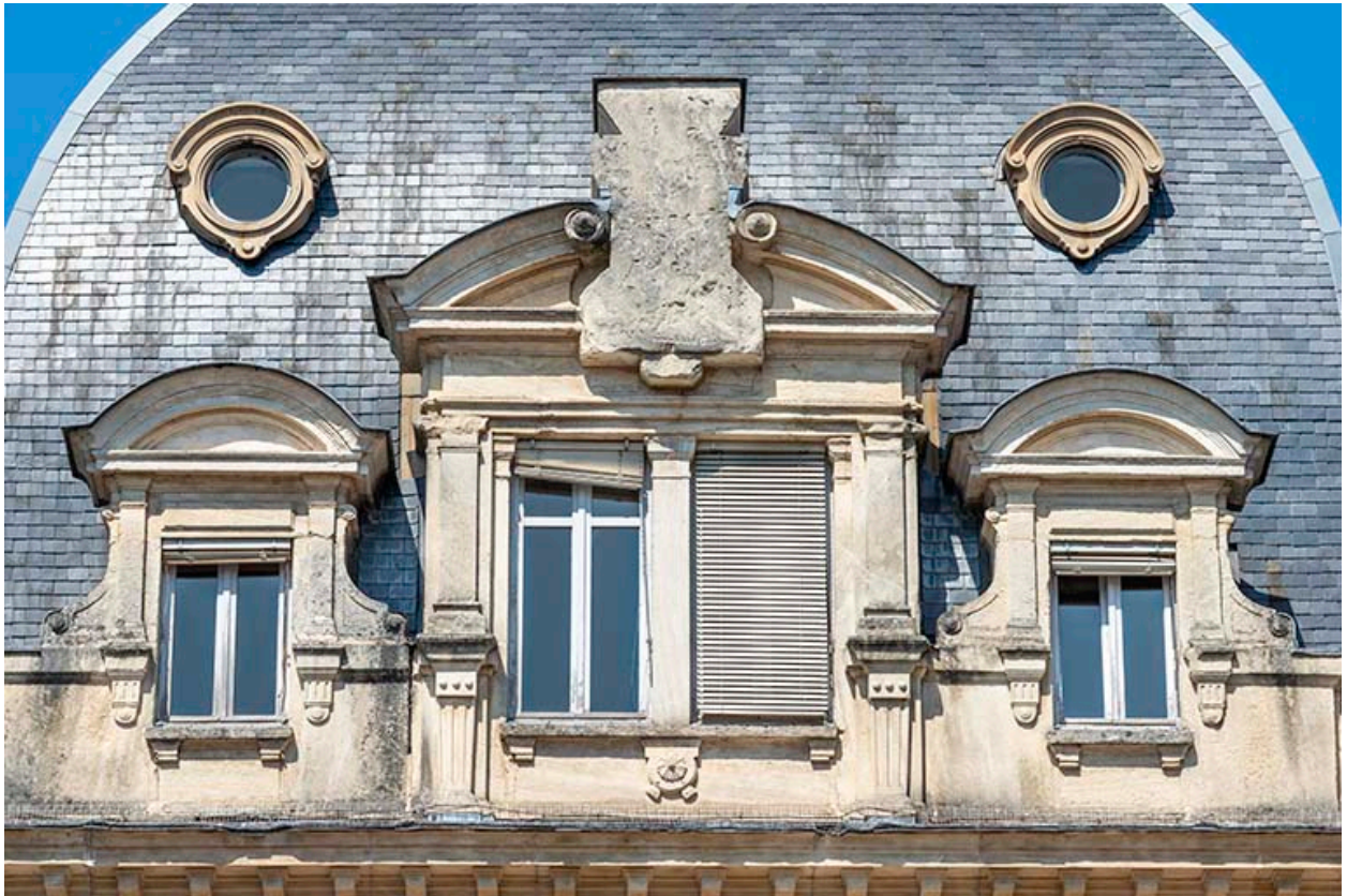
Bâtiment d'entrée, façade antérieure : lucarnes attique éclairant le 1er étage de comble du dôme.
