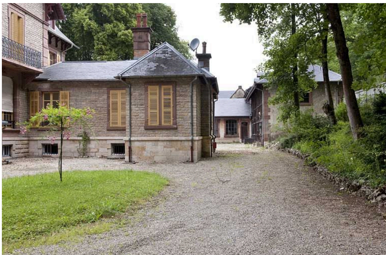
Façade sud de l'annexe et communs.
