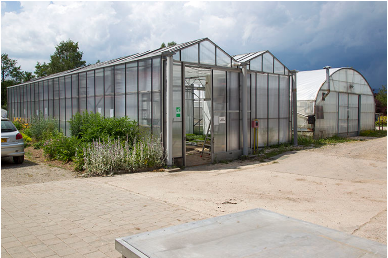
Serres au nord-ouest vues du sud-est.
