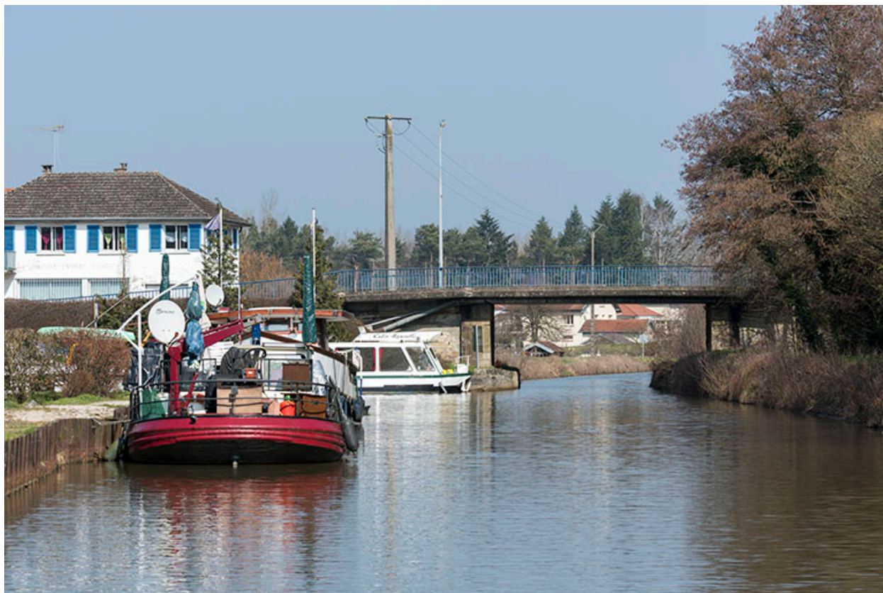
Pont sur le canal, vu de l'aval.
