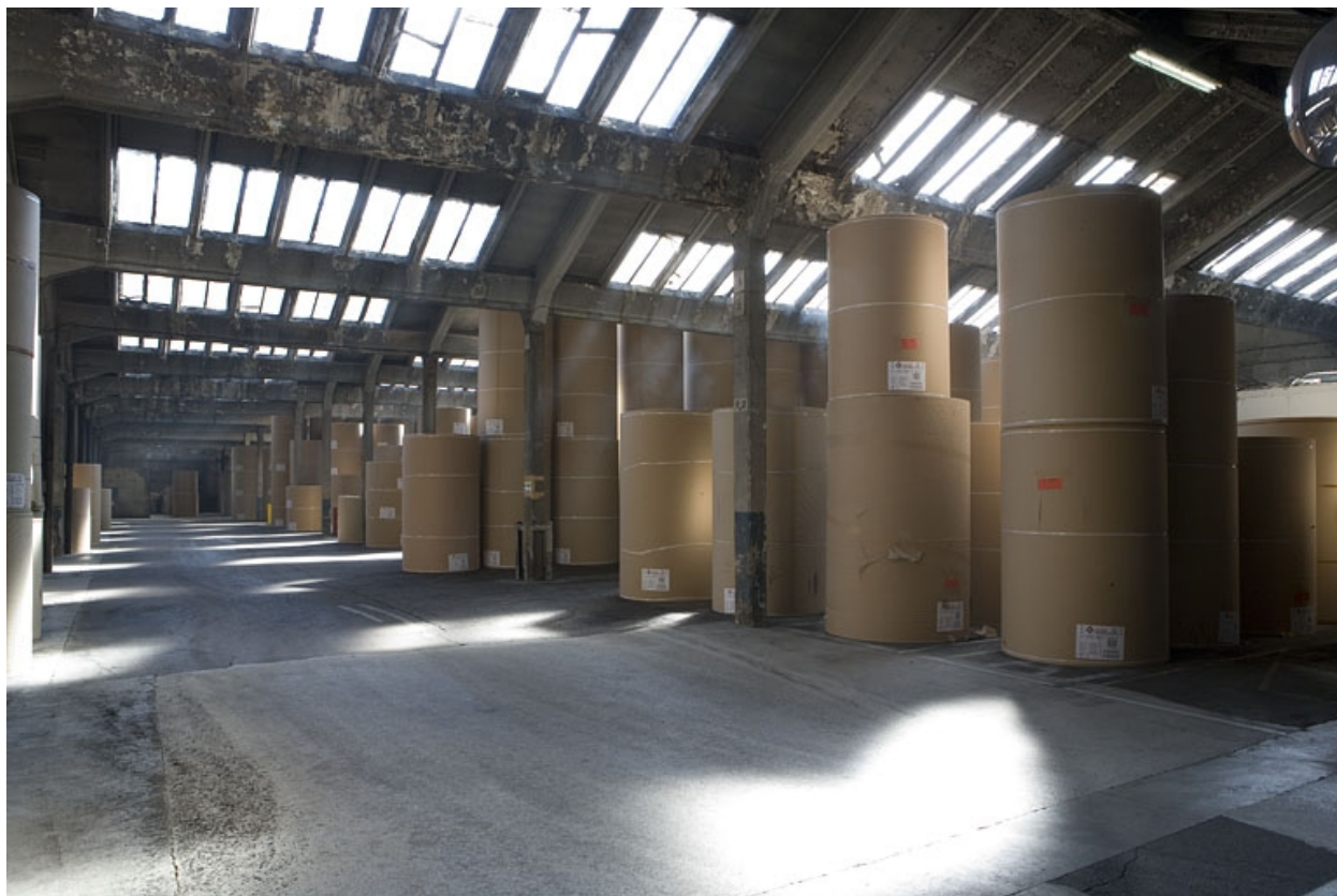
Magasin industriel. Vue intérieure.
