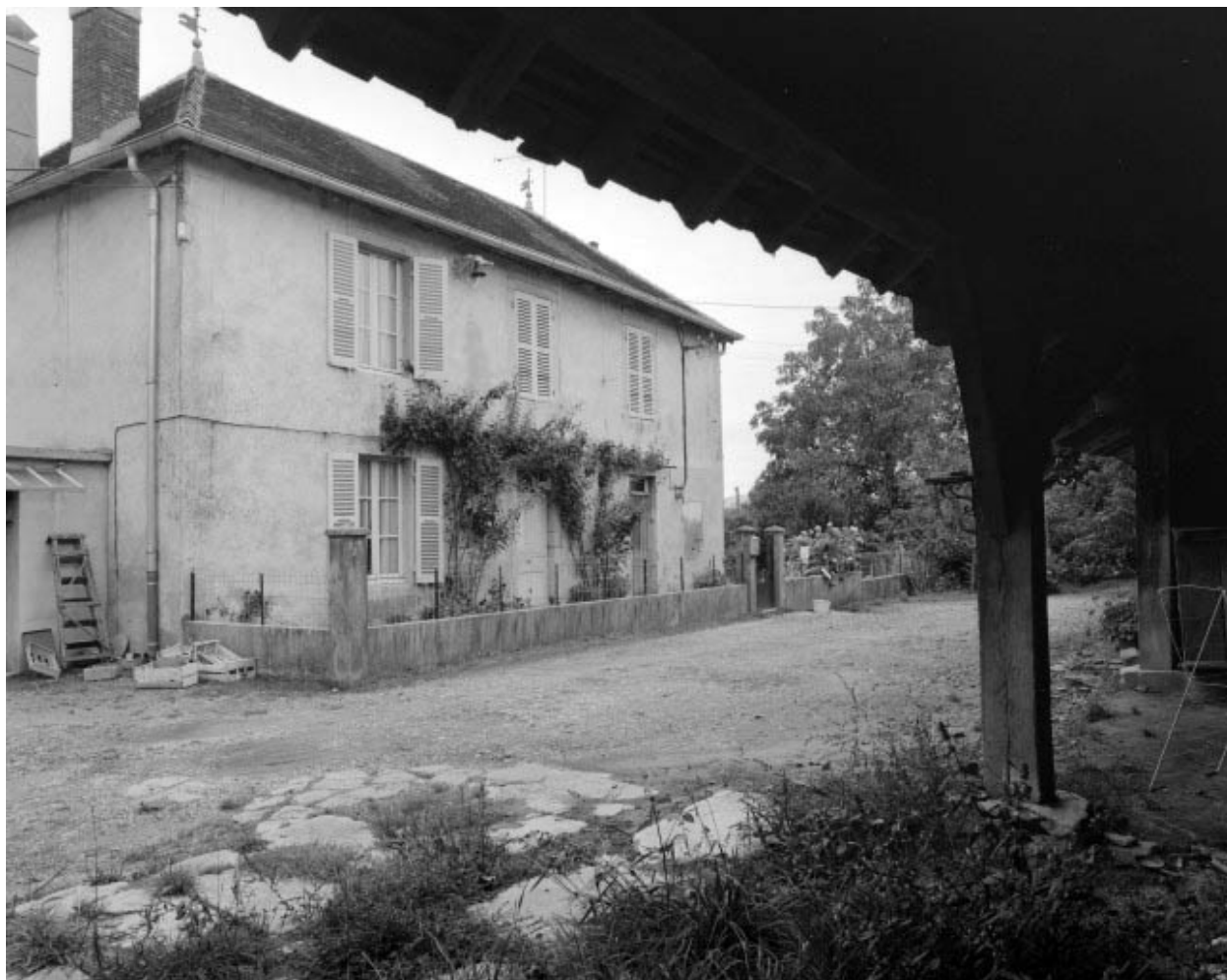
Logement patronal de trois quarts gauche.
