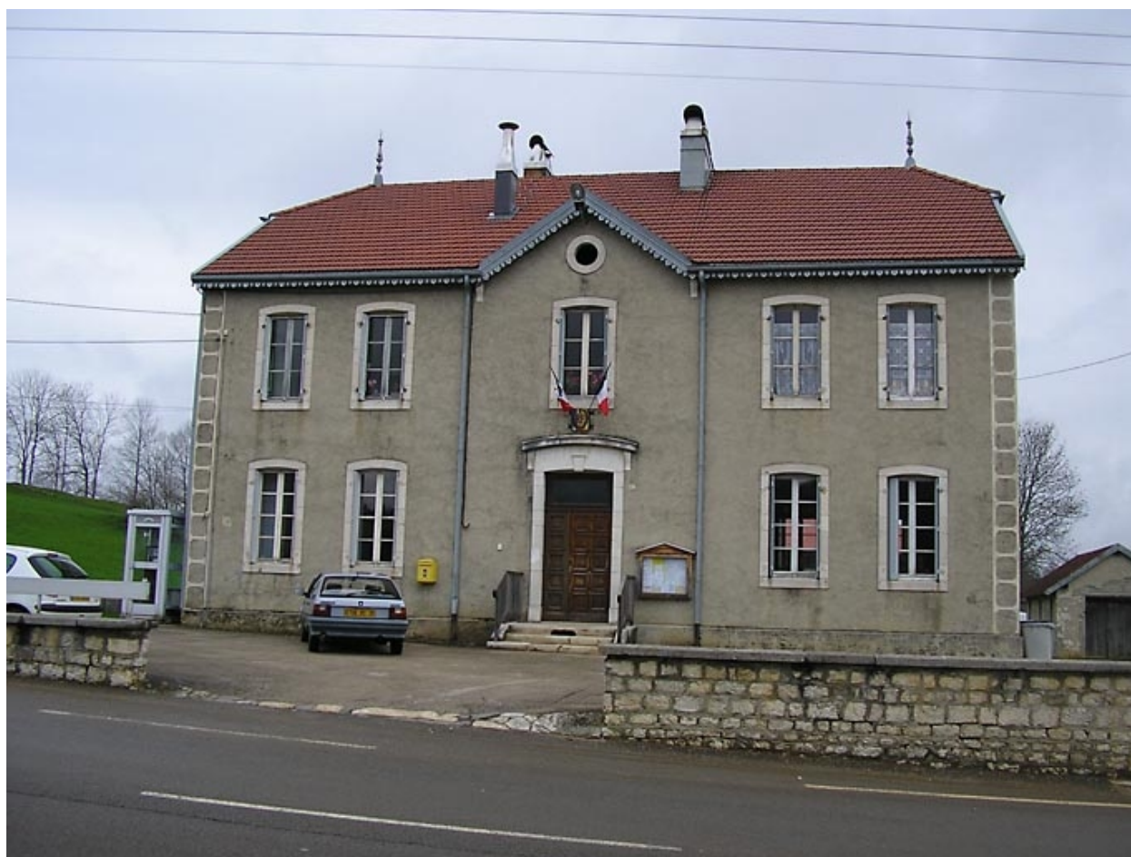
Vue générale de la façade antérieure.
