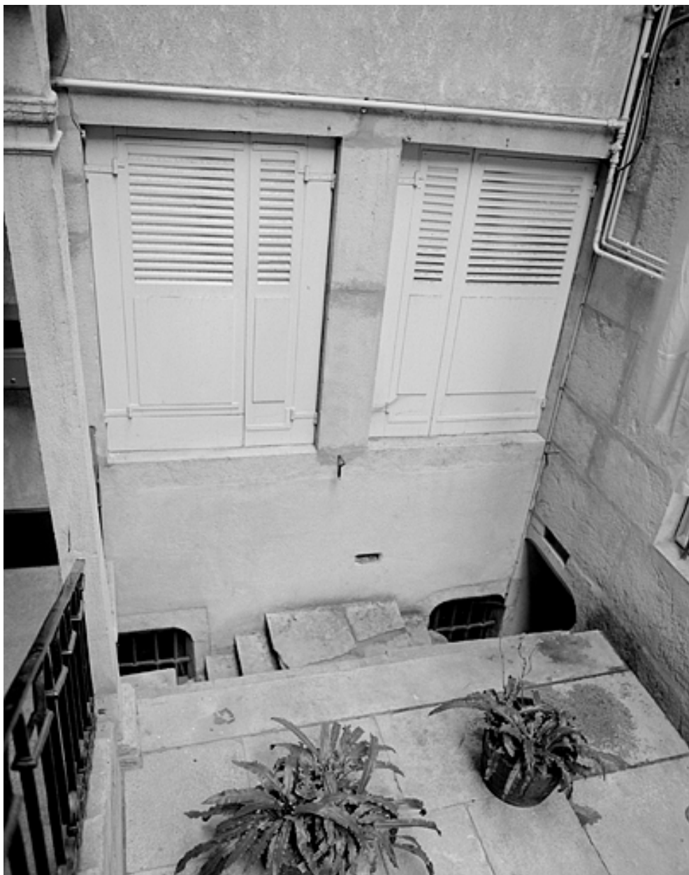
Descentes de caves dans la cour.
