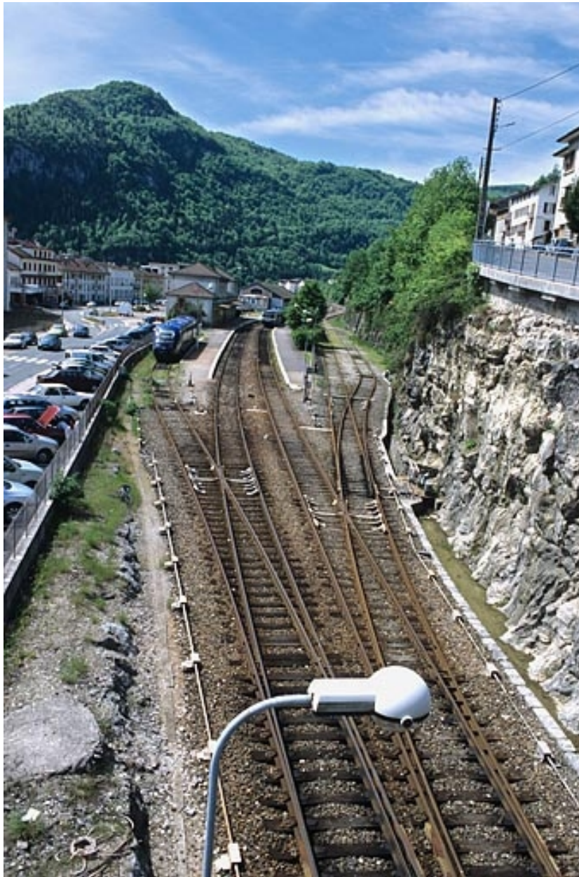
Vue d'ensemble depuis le pont routier, au nord.
