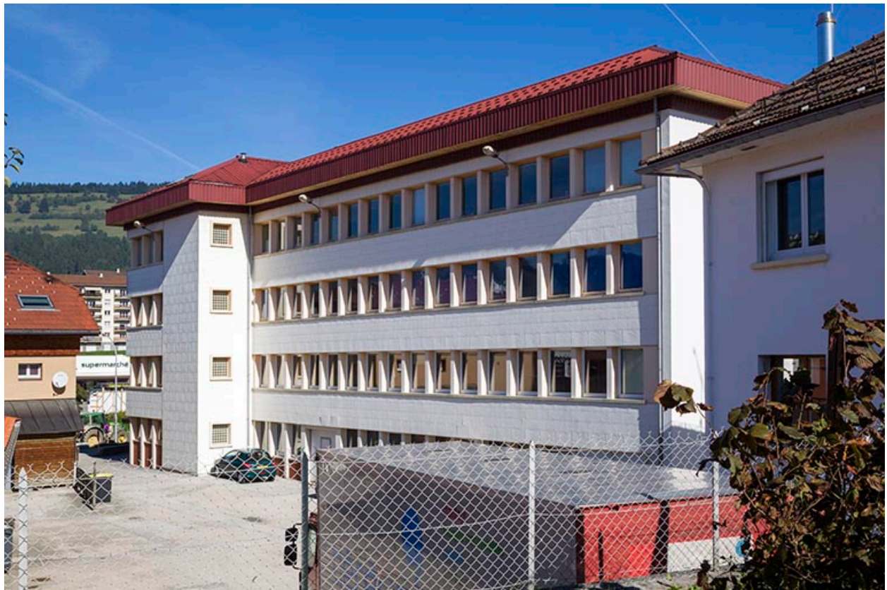
Usine : façade latérale droite, vue en enfilade.
