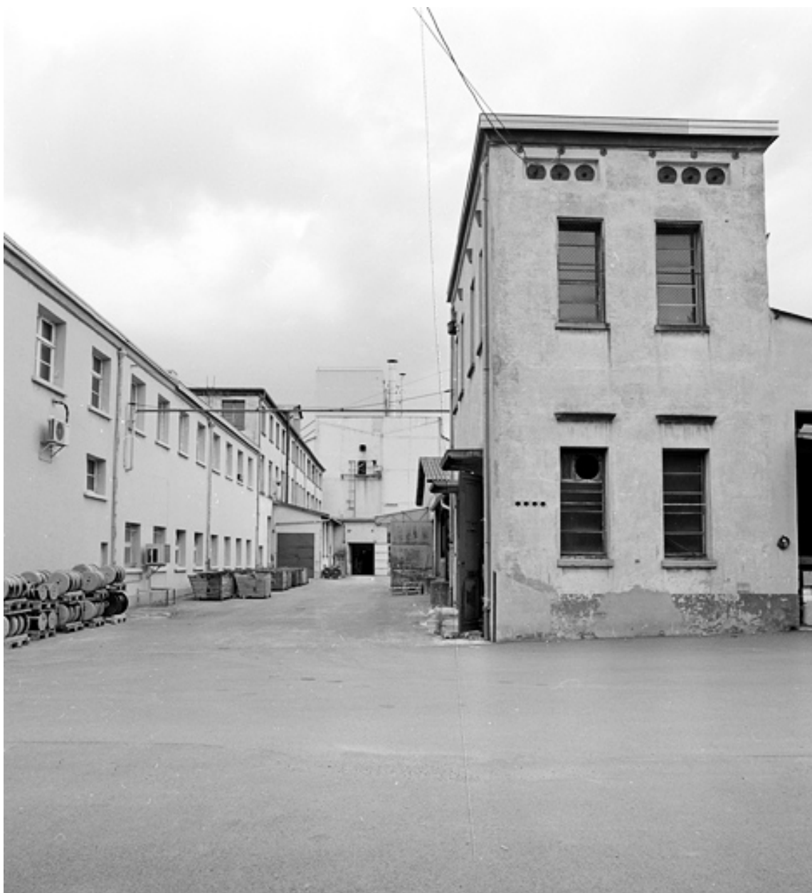
Bureau d'études (à gauche) et transformateur.
