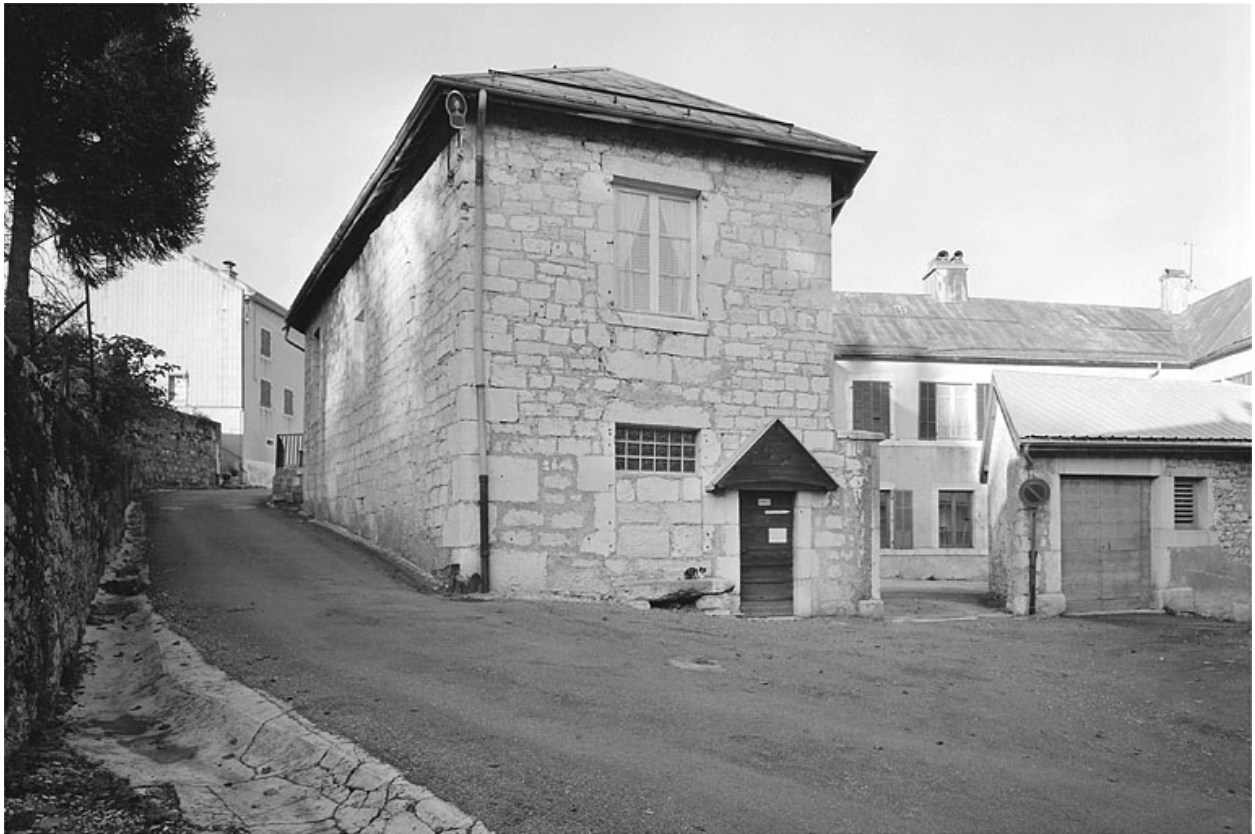
Vue générale, face sud-ouest.
