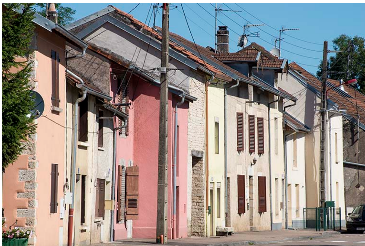
Alignement de maisons, rue du Magny.
