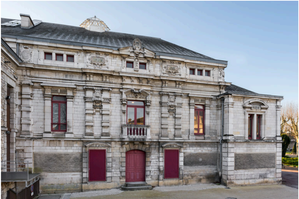
Façade latérale gauche : salle et vestibule.
