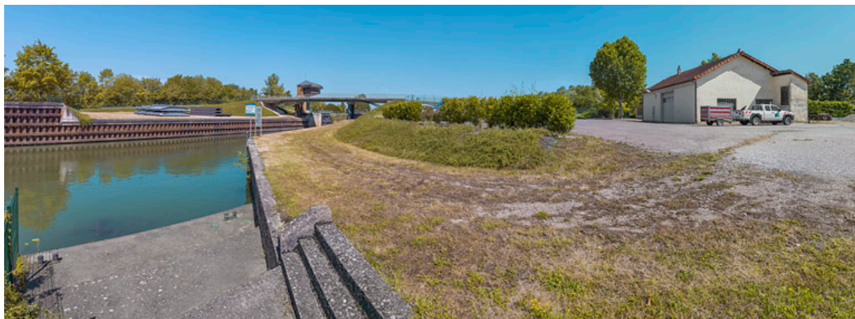
Vue d'aval du site et du centre d'exploitation VNF.
