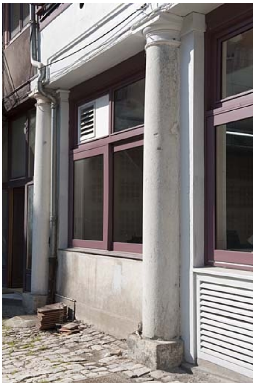
Détail du portique de l'aile sur cour.
