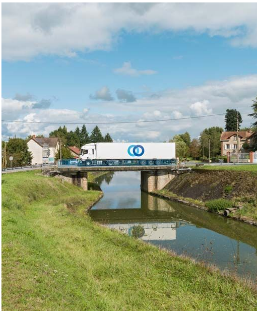
Vue d'ensemble du pont.
