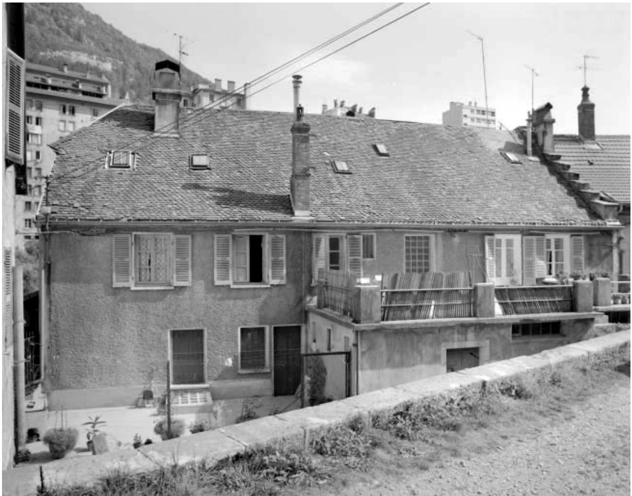
Logement d'ouvriers Dalloz : façade postérieure.
