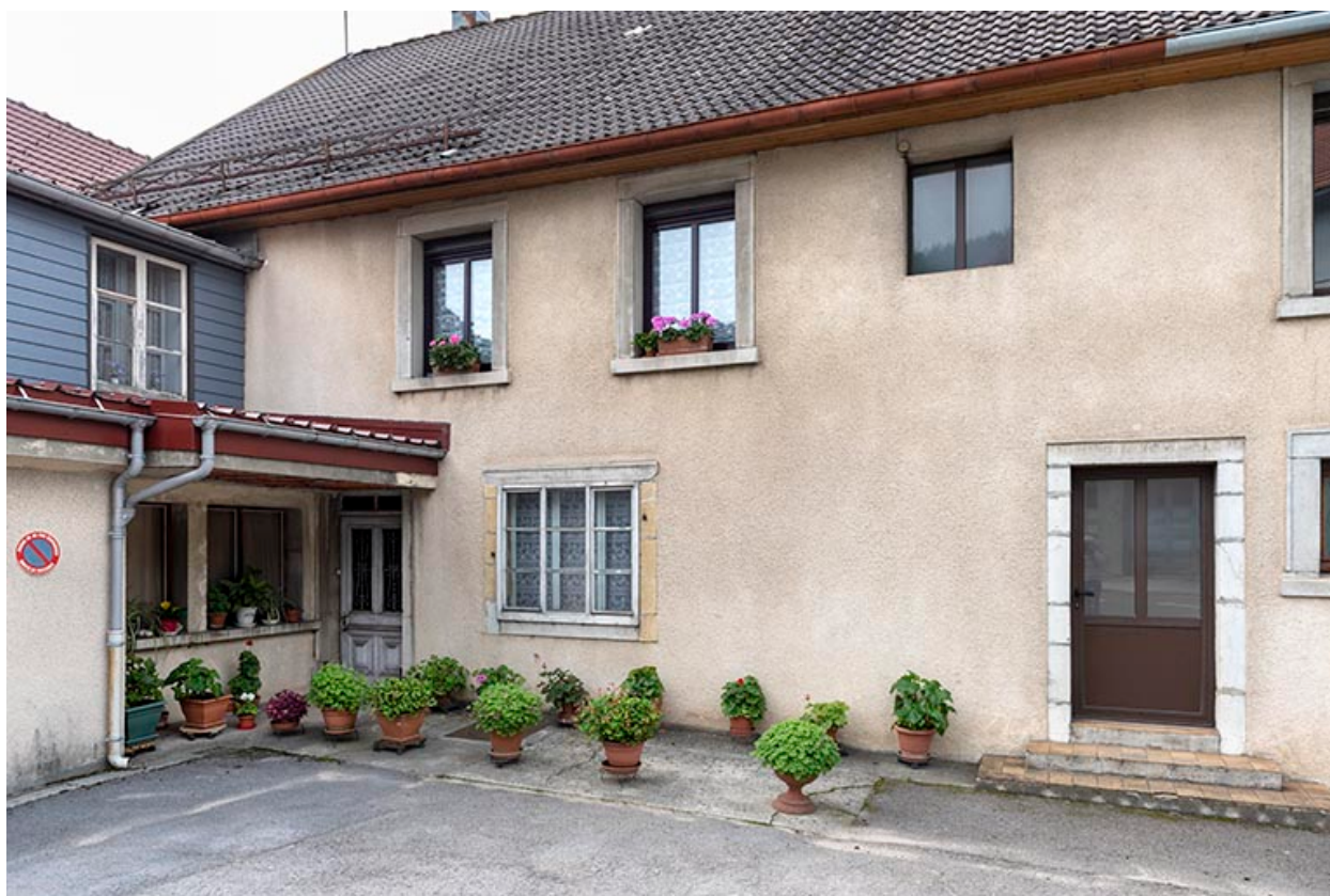
Ancien site : façade antérieure de la fonderie.
