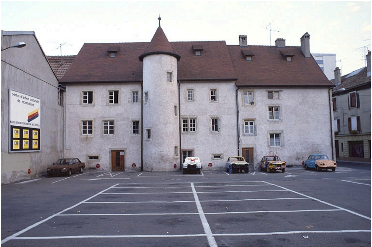
Façades sur cour des corps de bâtiment principaux de l'ancienne ferme.
