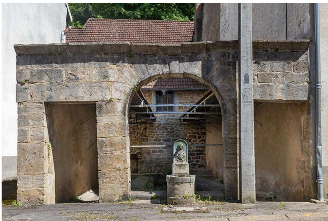
Face antérieure de la fontaine-lavoir.
