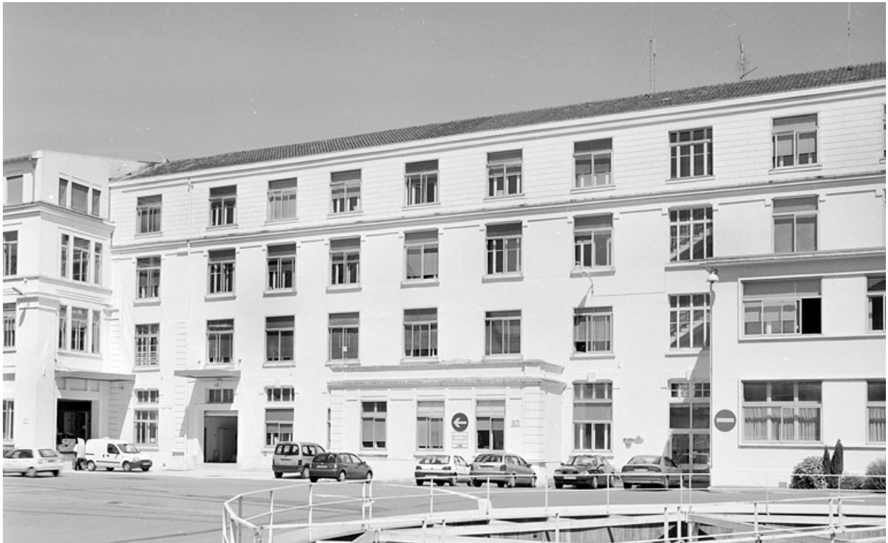
Bureaux et ancienne infirmerie.
