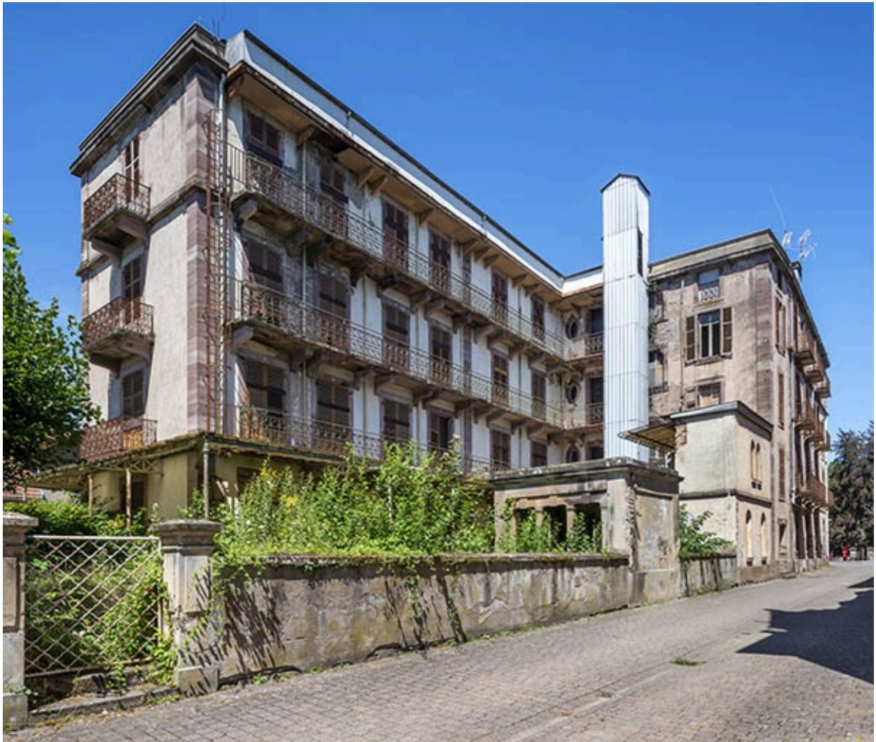
Façade de l'aile sud sur l'allée des Romains.
