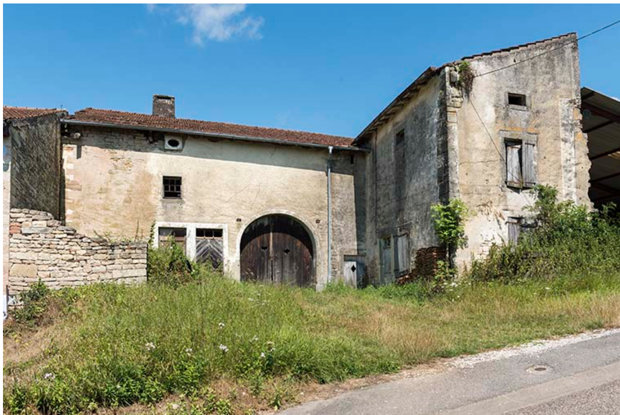
Ferme en retour d'équerre chemin de Seroux.
