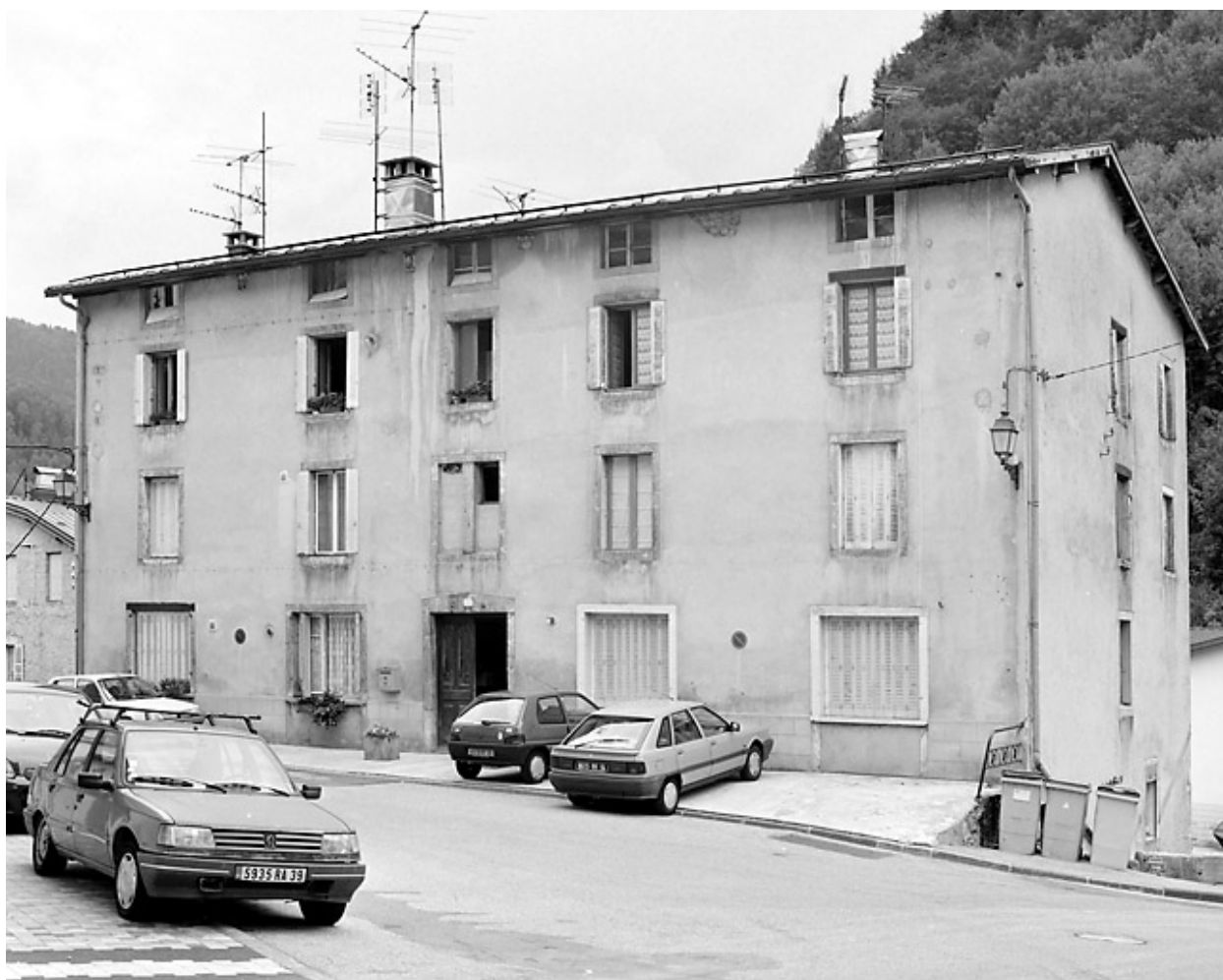
Elévation antérieure, de trois quarts droite.
