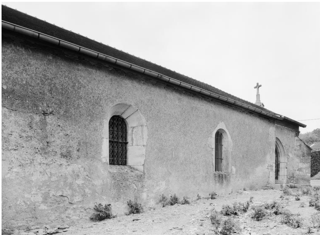
Elévation gauche de la nef.
