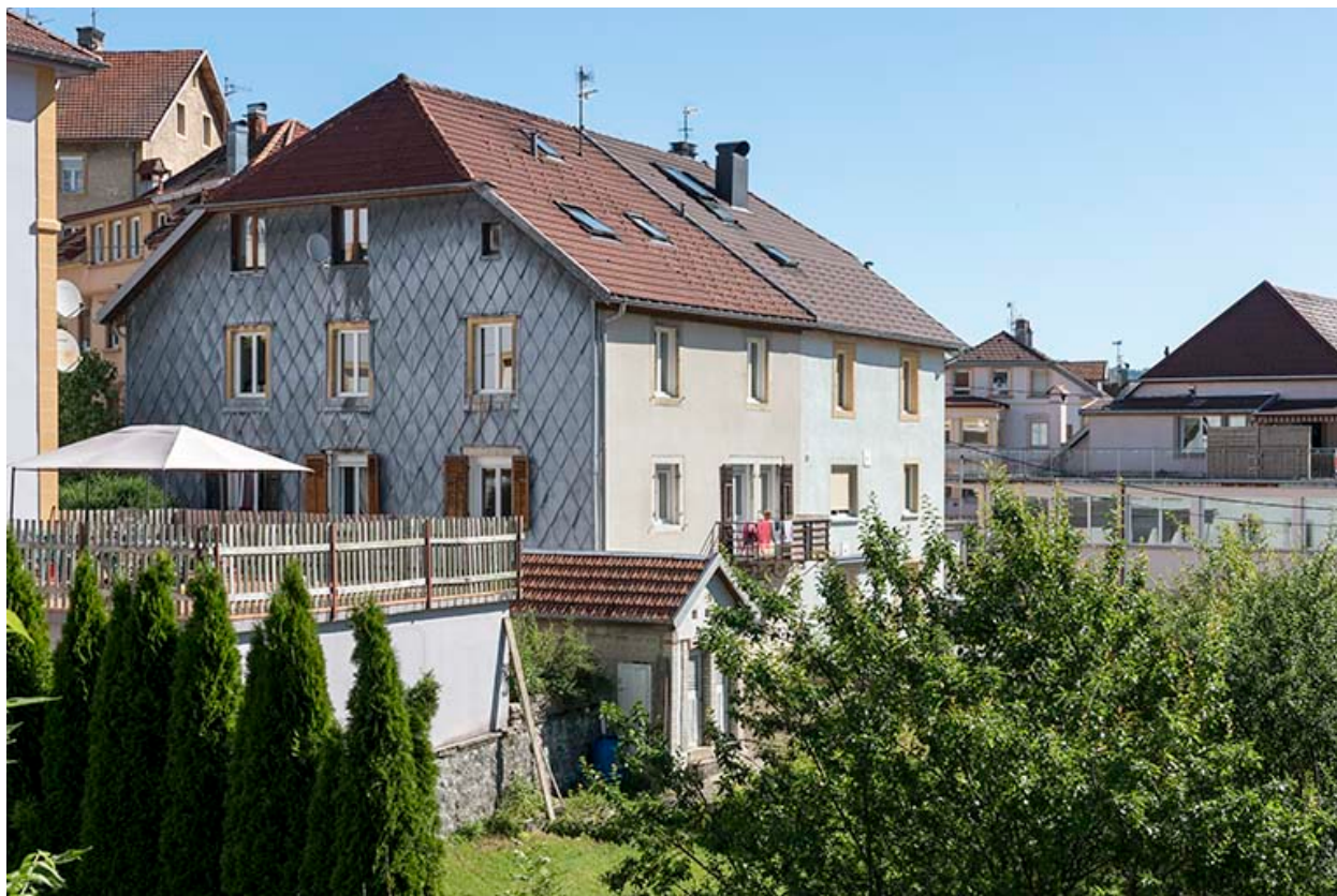
Façades postérieure et latérale droite.
