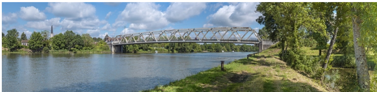
Vue d'ensemble, rive gauche.
