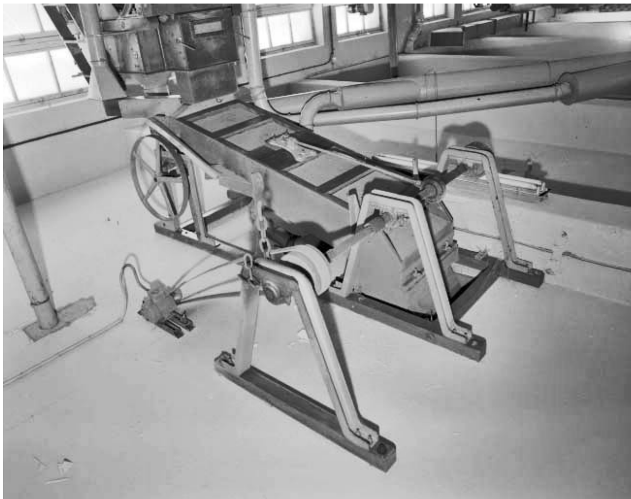
Trémie d'alimentation et distributeur vibrant.
