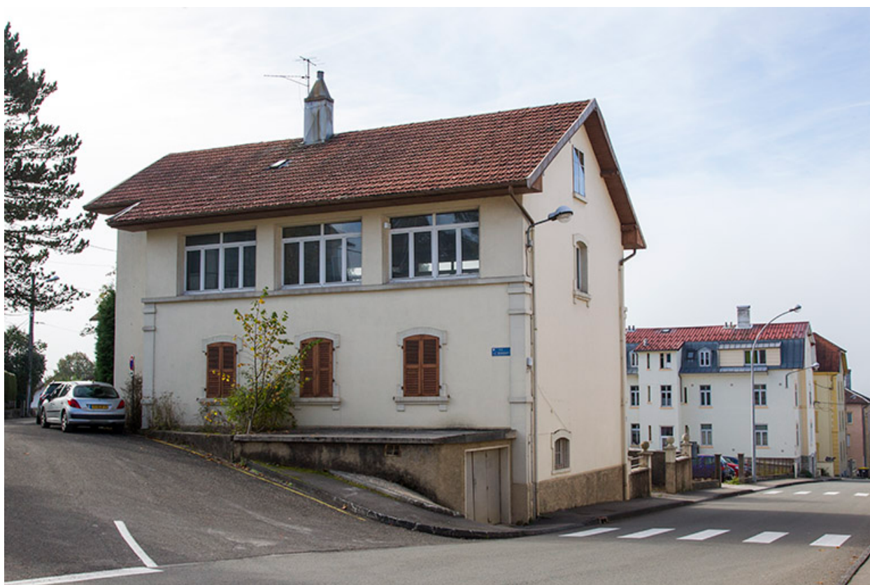
Façades postérieure et latérale gauche.
