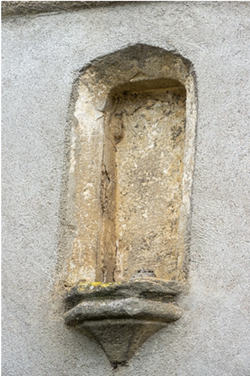
La rue Bontemps : n° 35, détail de la niche ménagée dans la façade.
