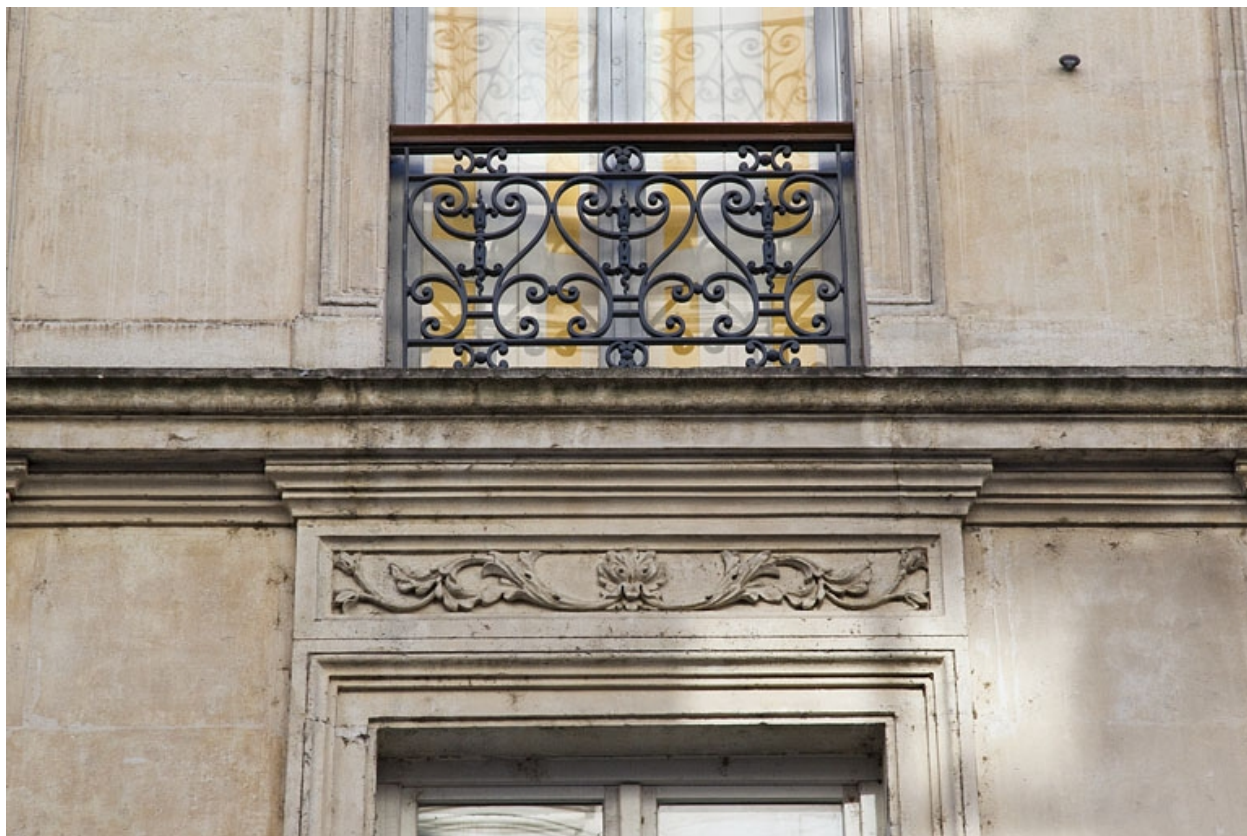
Façade antérieure : détail d'un garde-corps d'une fenêtre.
