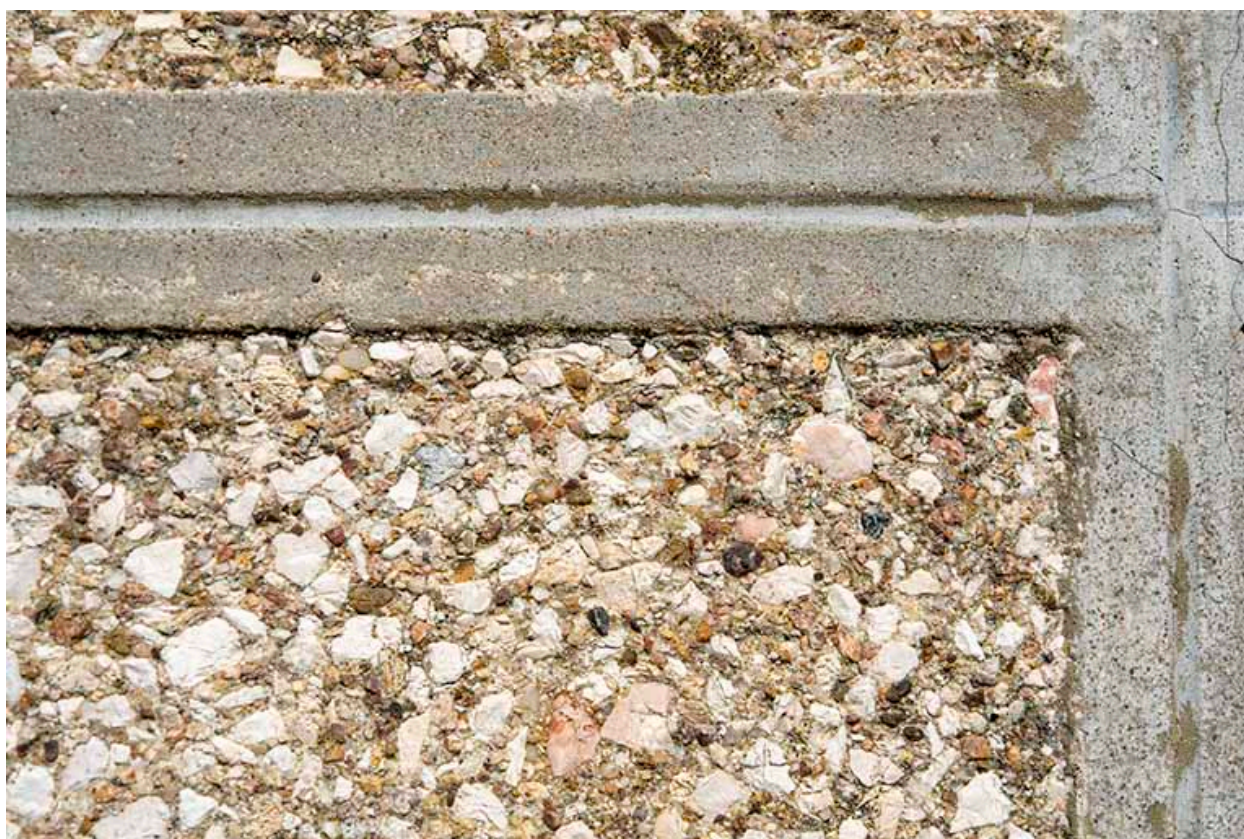
Détail de panneaux : aspect de surface et joints.
