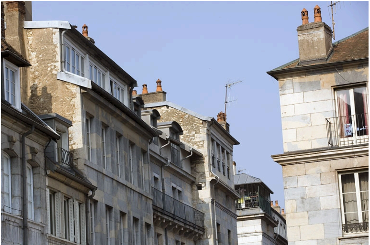
Partie supérieure de la façade sur rue.
