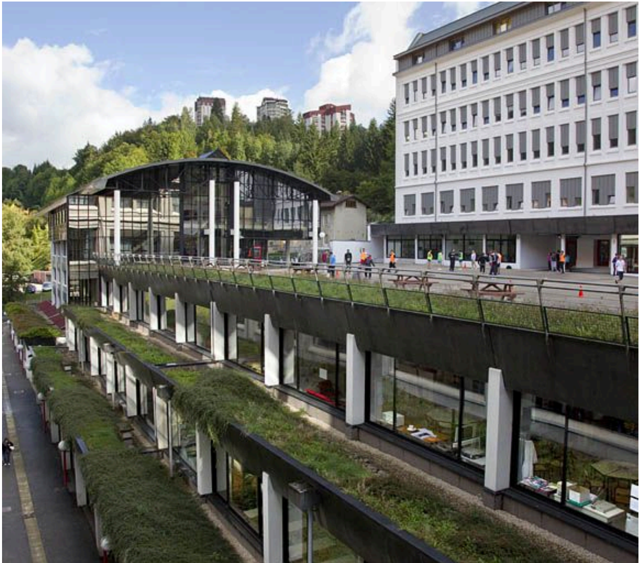
Bâtiments E et F : façade occidentale.
